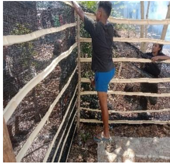
Pembuatan pagar dan pemasangan paranet
