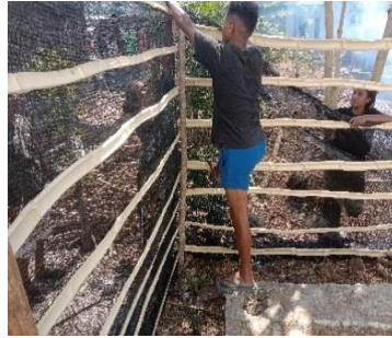
Pembuatan pagar dan pemasangan paranet
