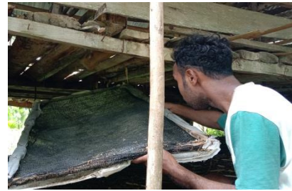
Pemasangan tempat Penampungan feses dan urin
