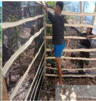
Pembuatan Pagar dan Pemasangan Paranet
