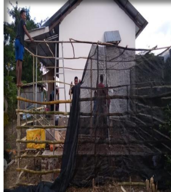
Pembuatan pagar dan pemasangan paranet
