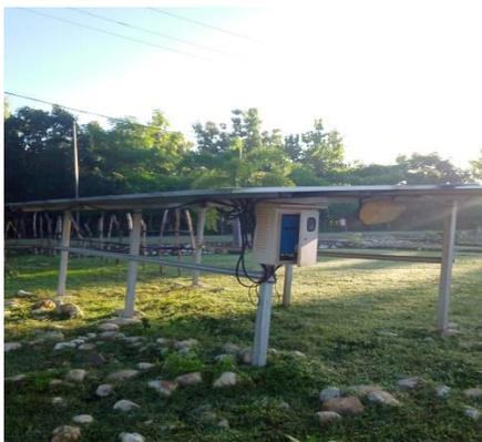
Tenaga Surya Untuk Mesin Pompa Air
