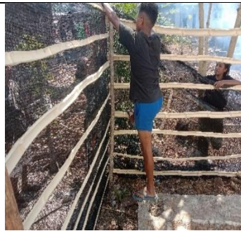
Pembuatan pagar dan pemasangan paranet
